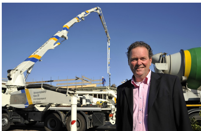
Op dit moment wordt hard gebouwd
